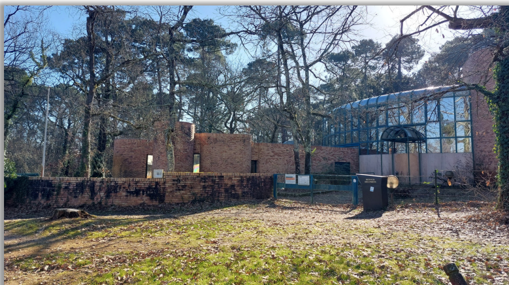
Bâtiment à réhabiliter (crédit photo : commissaire enquêteur)
