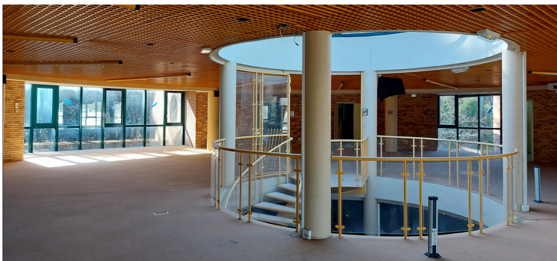
Etage du bâtiment à réhabiliter (crédit photo : Commissaire enquêteur, le 03/02/23)
