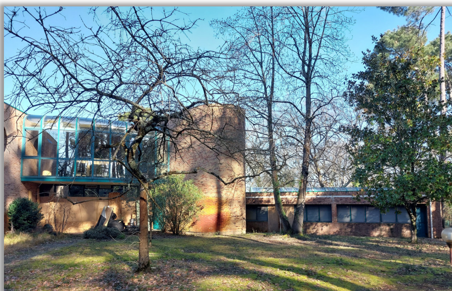
Bâtiment à réhabiliter (crédit photo : commissaire enquêteur)
