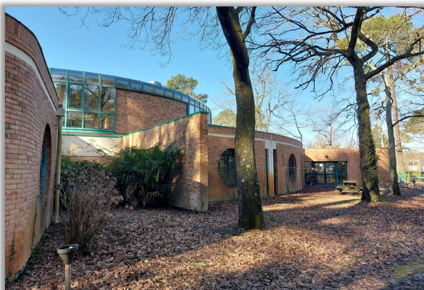
Bâtiment à réhabiliter (crédit photo : commissaire enquêteur)
